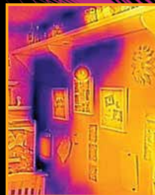
Carencias de aislamiento
